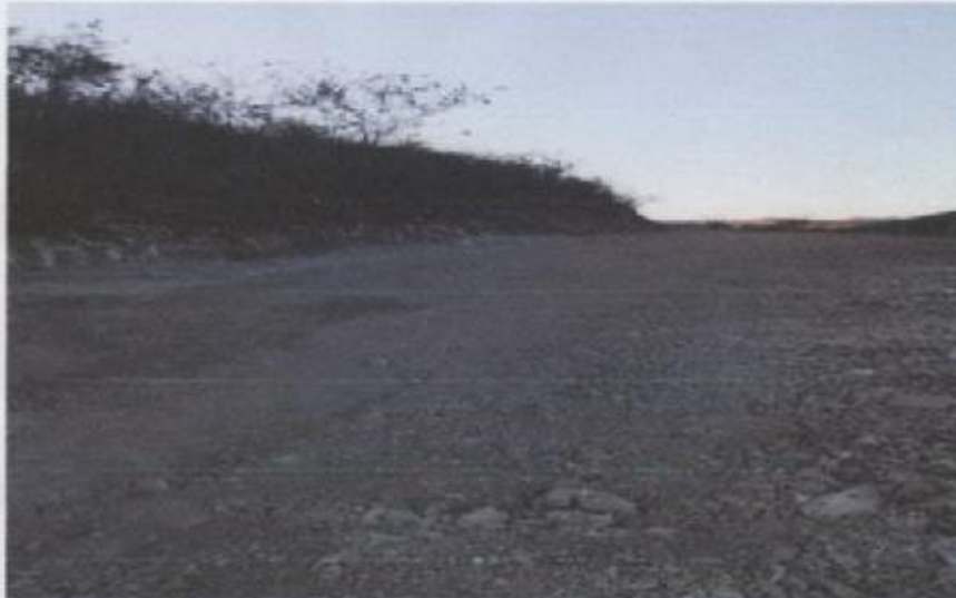
FIGURA 1.- VERIFICACION DE OBRA.
