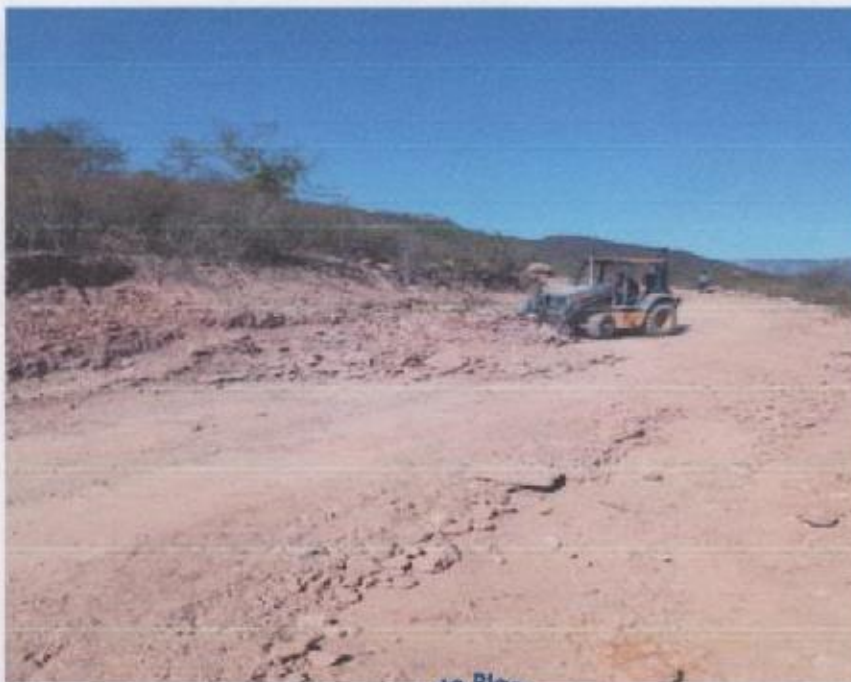
FIGURA 2.- VERIFICACION DE OBRA.
