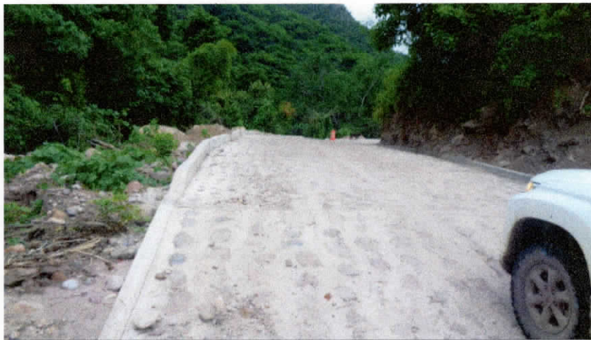
Fig4.- Visita para verificar los avances de Obras del tramo Jazmín del Coquito- Cuyultita de Jazmines.
