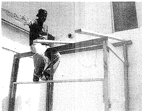
CONSTRUYENDO BODEGA DE CLORACION
