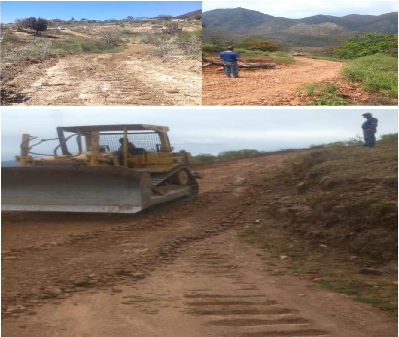
Se rehabilitaron 45.00 kilómetros de Zoquipan a la localidad de Jesús María; mediante el rastreo con equipo mecánico, excavación en corte y terraplén en caja o balcón con material producto de corte. En beneficio de más de 365 personas.
