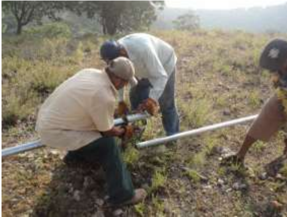
Gente de la localidad trabajando en la obra de el capomo
