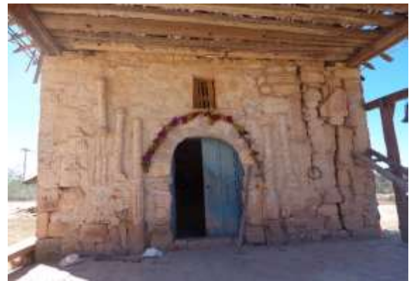
Antes de Rehabilitacion.
