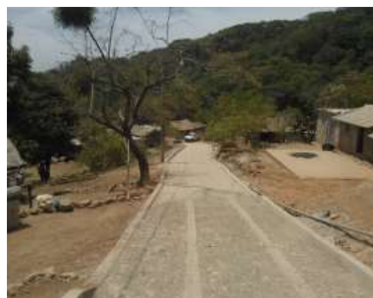
Concluidos los trabajos
