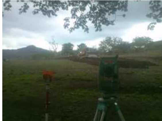
Equipo para trazo y maquinaria
