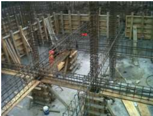
Cimbrado de estructuras.
