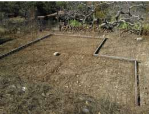
Cimentacion de Vivienda
