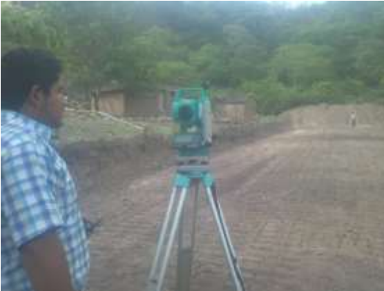
Llegada a la localidad de la palmita Y apoyo en la Rehabilitacion de campo de futbol
