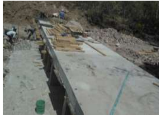
Descimbrado de Estructura
