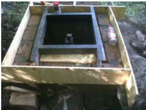
Colado de H en valvulas
