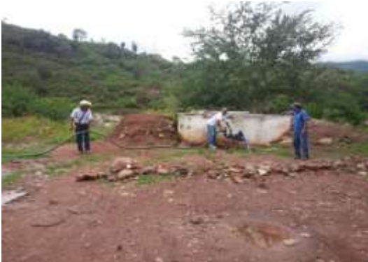
Reparación de Sistemas de Agua.
