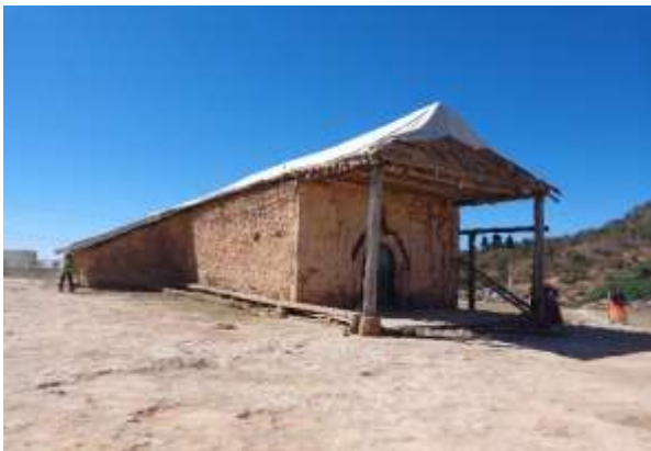
Antes de Rehabilitacion.
