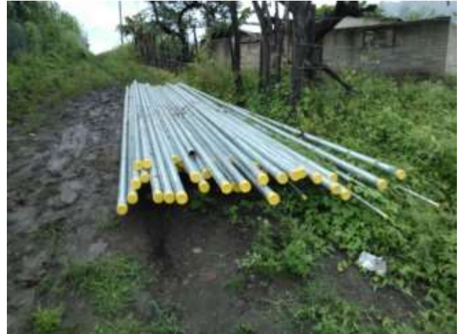
Abastecimiento de Tubería.
