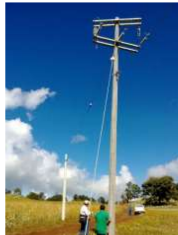
Posteria para el carcamo de bombeo.
