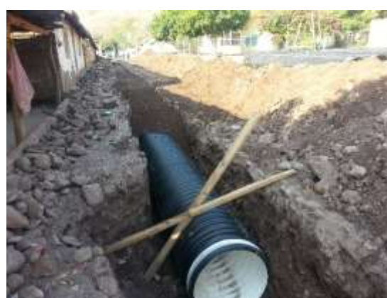
2) Abastecimiento de Tubería.
