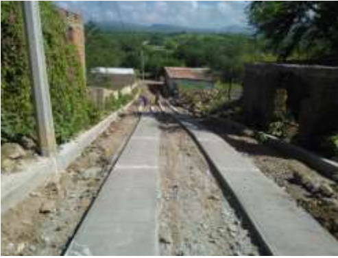
Colado de Huellas de concreto
