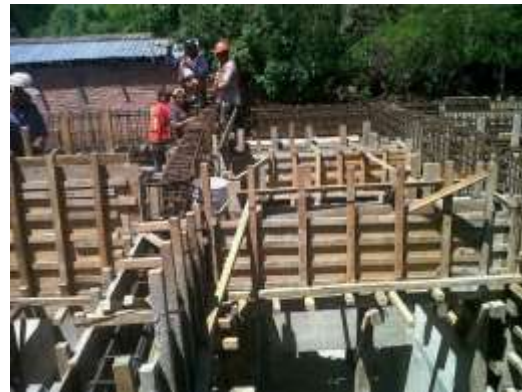
Cimbrado de las estructuras.
