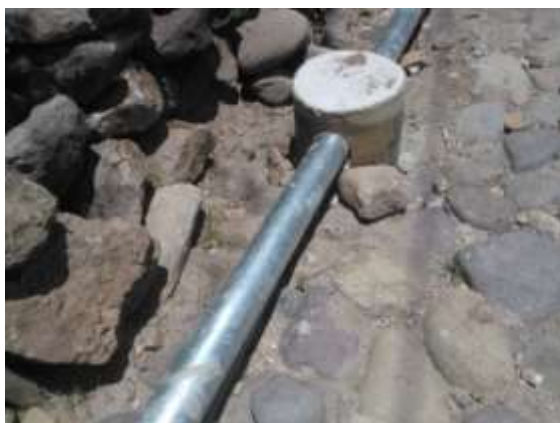
Construcción de atraques
