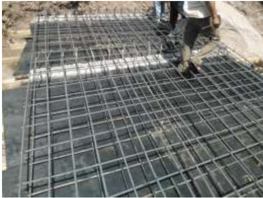
obra Armado de Estructuras
