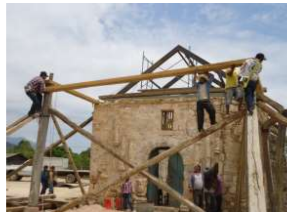
Durante la Rehabilitacion
