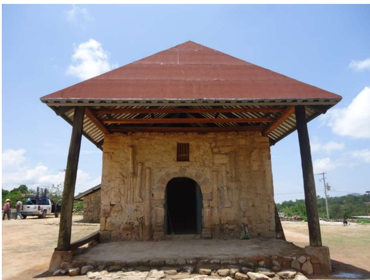
Obra ya concluida
