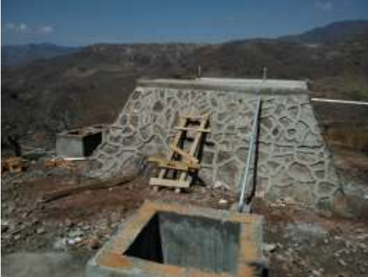
Construcción de Tanque de almacenamiento.
