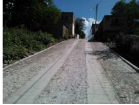
Obra ya concluida
