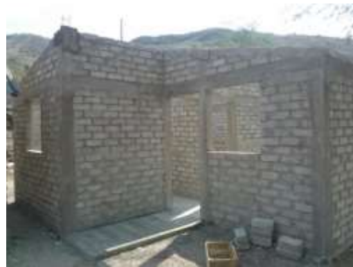
Casa en obra negra.
