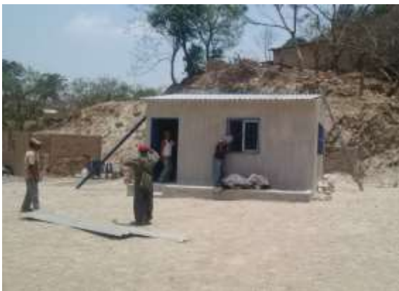
Colocacion de Herreria
