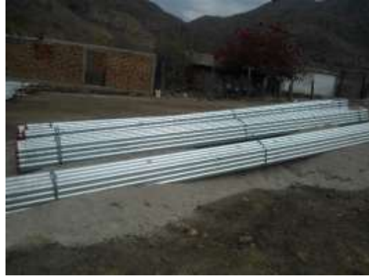
Abastecimiento de Tubería.
