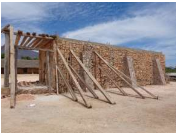
Durante la Rehabilitacion
