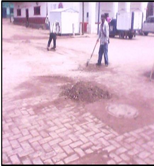
Limpia de lodos en adoquín
