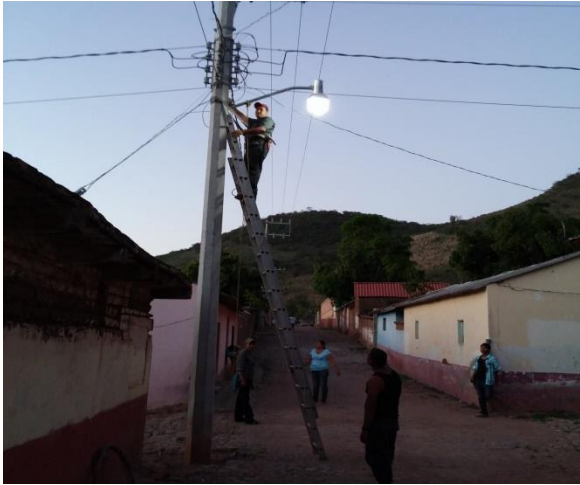
Rehabilitación de alumbrado público
