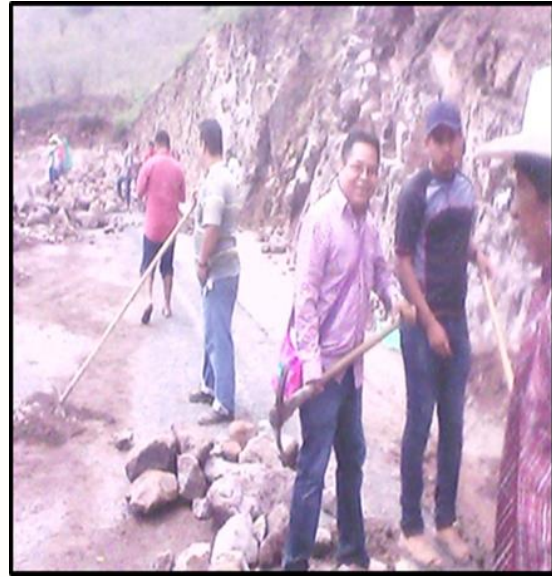
Limpia de derrumbes en carretera
