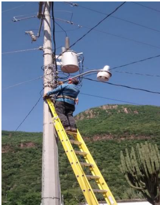
Rehabilitación de alumbrado público
