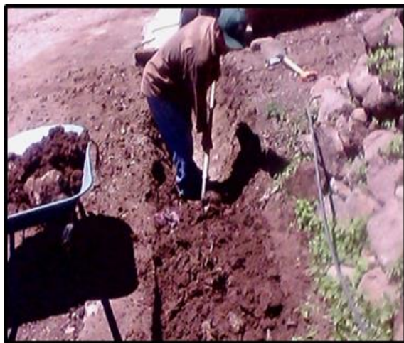
Limpieza de cunetas
